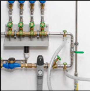
Spülen von Trinkwasserinstallationen mit Wasser oder Wasser/Luft-Gemisch 1)3)4)
